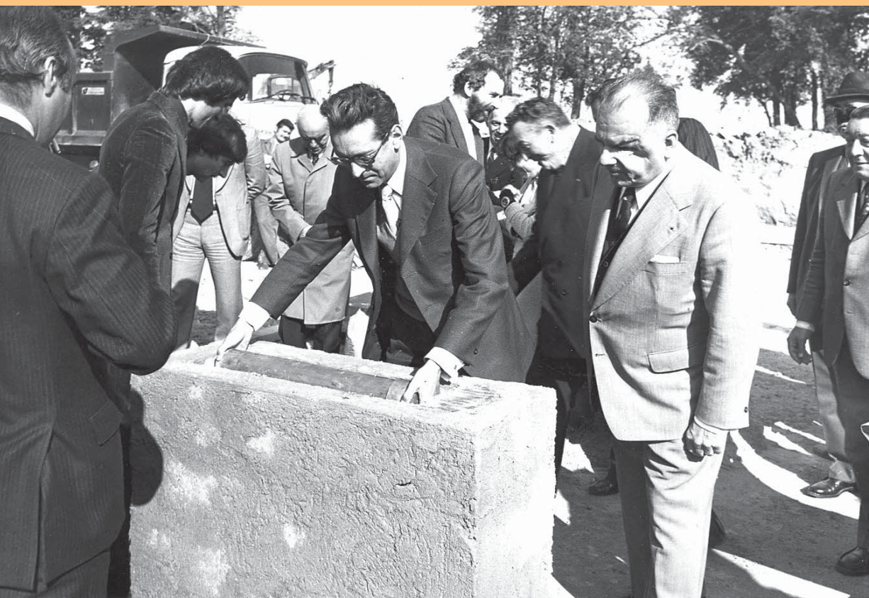
Pose de la première pierre du centre de traitement du Loto à Moussy-le-Vieux.
